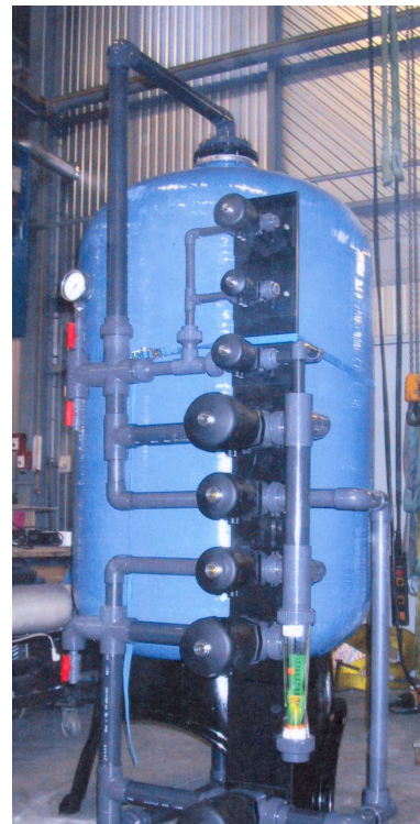
CUVE FRETTE POLYESTER AVEC TUYAUTERIE
