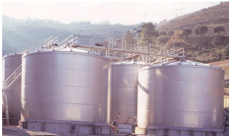
CUVES DE STOCKAGE
